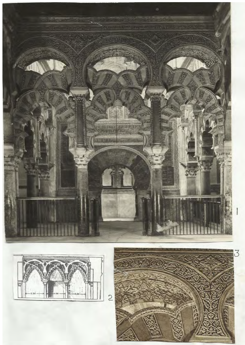
Figura 23. , Cara exterior de la entrada a la qubba de delante del mihrab, los arcos de herradura superiores sin dovelas.
