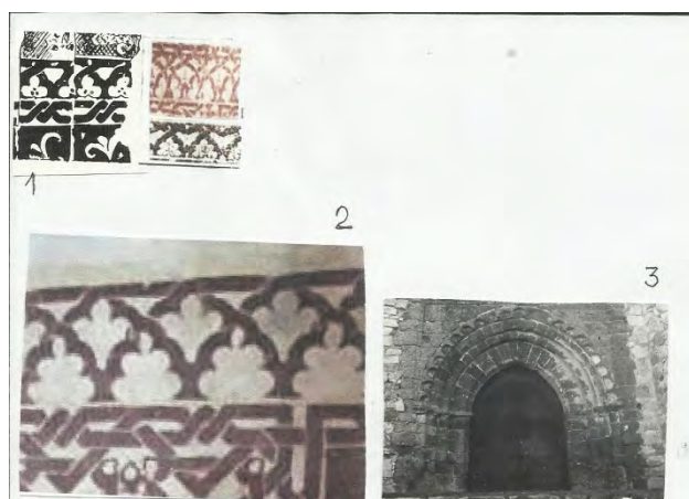
Figura 100. A, modelo de arcos de herradura apuntada con lóbulos pegados a la rosca, Aljaferia; derivados los restantes arcos.
