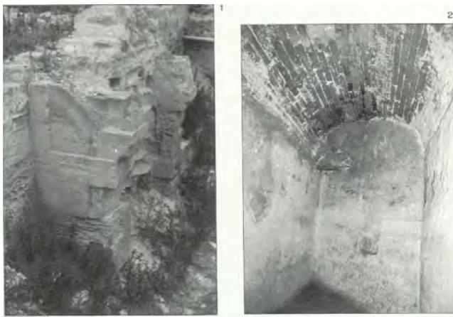
Figura 4. A, Frente interior con uno de los arcos de puerta de piedra, siglo X-XI; B, bóveda del aljibe del segundo recinto con sillares apaisados. Fotografías del año 1997.
