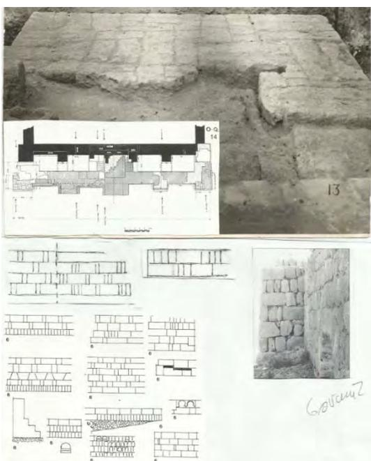
Figura 5. Testero de la mezquita aljama de al-Zahra, los aparejos vistos desde arriba, se trata de obra en cimientos. Debajo aparejos de soga y tizón, distintos tipos de Córdoba, incluido algún modelo romano arabizado; a la derecha un prototipo de paramento en torre califal del castillo de Gormaz.
