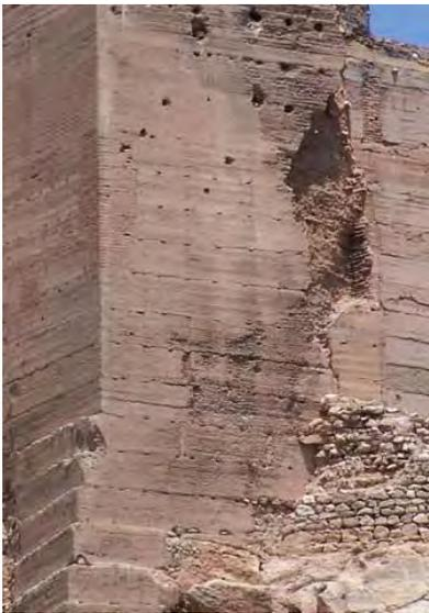
Figura 18. Imagen clásica del siglo Xi de la muralla de la Hoya Vieja de Almería. Esta vez el zócalo de refuerzo sustituido por serie de zarpas según técnica heredada del califato. Los paramentos conservan las huellas de las tablas del armazón o caja para encofrado. Vista parcial de fotografía publicada por Gurriaran Daza. Recuérdese el abuso de zarpas en una de las torres del castillo califal de Gormaz y Márquez Bueno.
