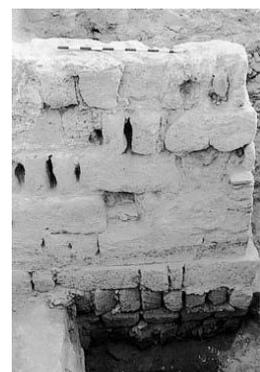
Figura 4-1. Muralla y torre con aparejo de soga y tizón del siglo X en la zona de las Atarazanas, Parque de Nicolás Salmerón, muralla oriental de la medina califal (ilustraciones de *Almería musulmana y cristiana*. Junta de Andalucía. 1990).
