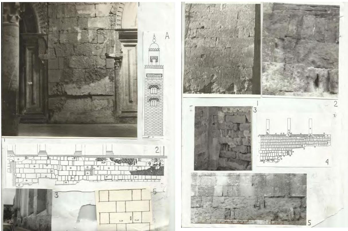
Figuras 12 y 13. Muros con soga y tizón de la mezquita emiral de Córdoba: 1, en superficie; 2, cimientos según Marfil Ruiz; 5, muro emiral según Gómez-Moreno; 5, el alminar de Abd al-Rahman III, según F. Hernández. Figura 13. Paramentos de la ampliación de Almanzor de la mezquita aljama de Córdoba..
