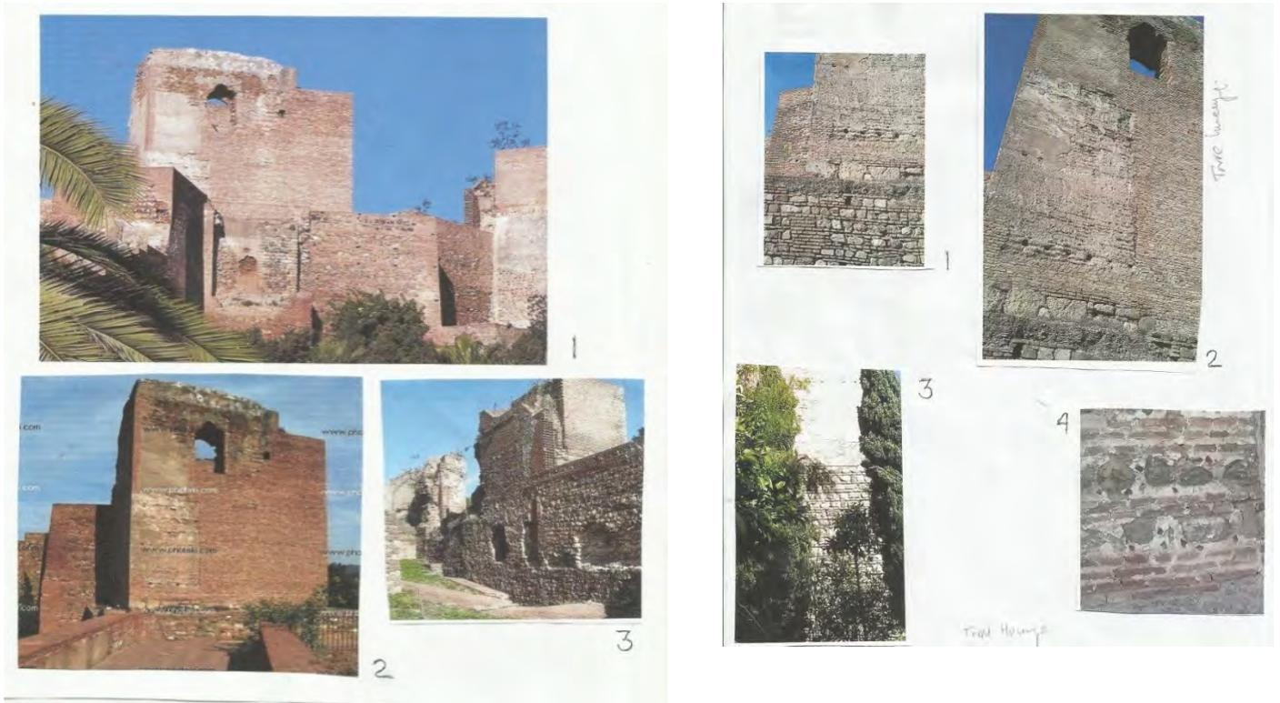
Figura 16. Varios aspectos de la Torre del Homenaje en la que debido a las restauraciones de todo tiempo se confabulan el tapial hormigonado, el ladrillo, por zócalo mamposterías con verdugadas de ladrillo sencillas o dobles<sup>58</sup>
