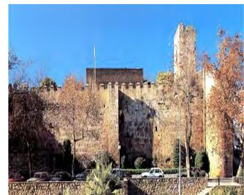
Figura 33. Alcazaba de Marbella. 1, 2, vista de torreón de ángulo con grandes sillares aprovechados en la base; 3, paramento de sillares omeyas.
