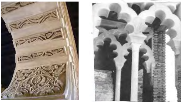
Figura 4. Interior o papo de arco con decorados de yesería complemento de los salmeres y dovelas frontales siguiendo modelo califal de al-Zahra. A la derecha arcos lobulados, el lóbulo clave con nudo circular como los arcos lobulados de la Aljafería y angrelado de arco toledano del siglo XI, nudos hasta hoy inéditos en Jaén, Córdoba, Granada y Almería.
