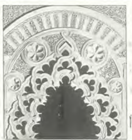
Figura 21. Respecto a la arquitectura califal de Córdoba la transgresión en la Aljafería en el tema de arcos entrecruzados alcanza su exponente más expresivo en este arco: arco de descarga adovelado y angrelado a base de arcos lobulados con nudos circulares. Se trata de la expresión más sofisticada de la arquitectura de al-Andalus.
