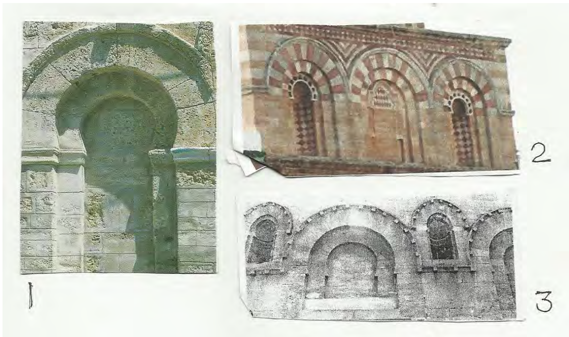
Figura 8. Arcos con archivoltas. Mezquita Sidi Ali Ammar de Susa, 1; arcos superiores de la fachada, qubba de los pies de la Zaytuna de Túnez, mixtilíneo el arco central, 2; fachada de la mezquita mayor de Sfax, 3.
